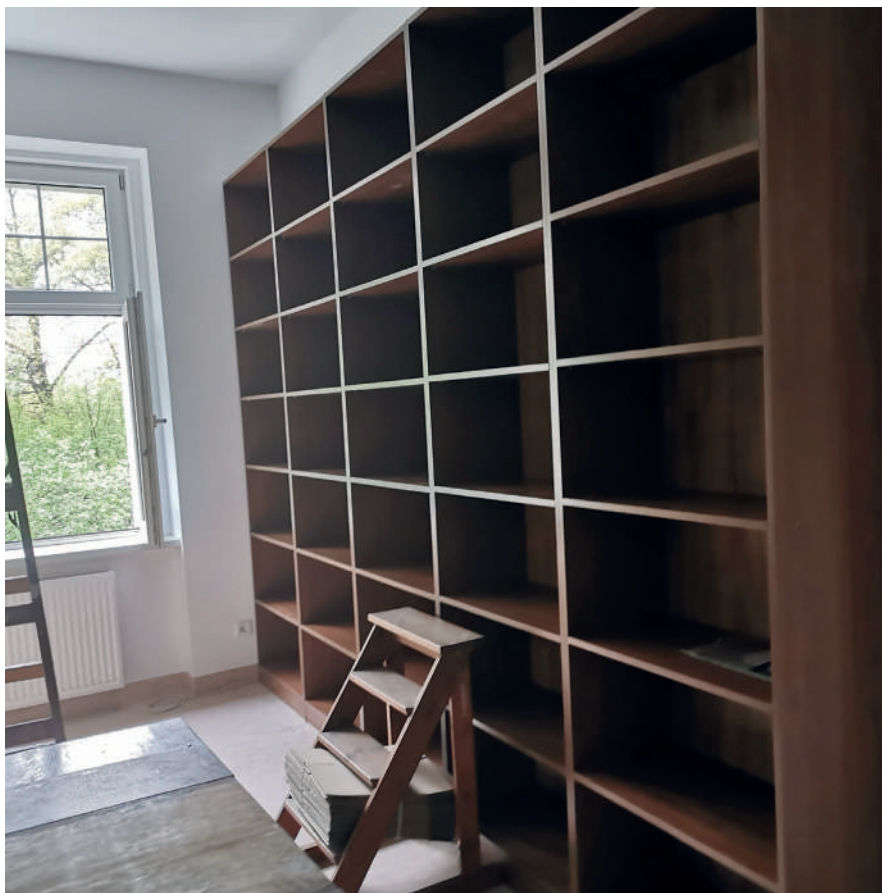
Pomieszczenie nowego Archiwum WTN przed rozpoczęciem prac
